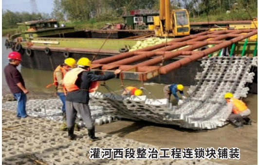
灌河西段整治工程连锁块铺装
